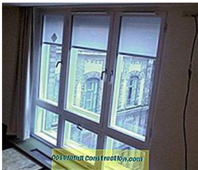
Фиг.12. Интегриране на вентили за захранване с въздух и засенчване на щорите в двойните прозорци
